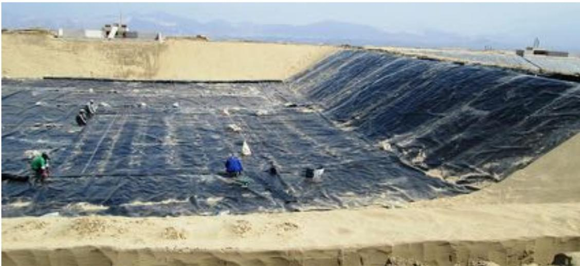
Figura 4. Construcción de reservorios para agua.
